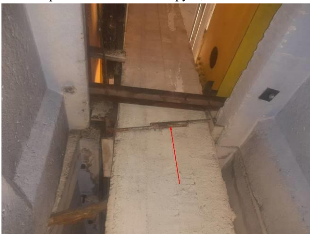
Фото 51. Вид на крепление верхних поясов подкрановых балок к конструкции колонны.
