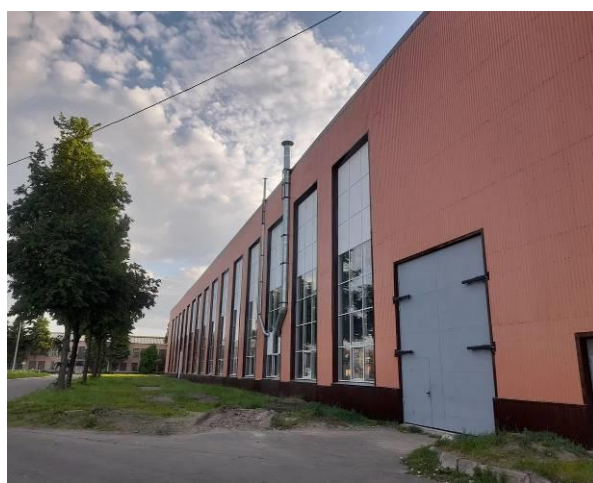
Фото 2. Общий вид на часть фасада здания в осях Я/1-А'.
