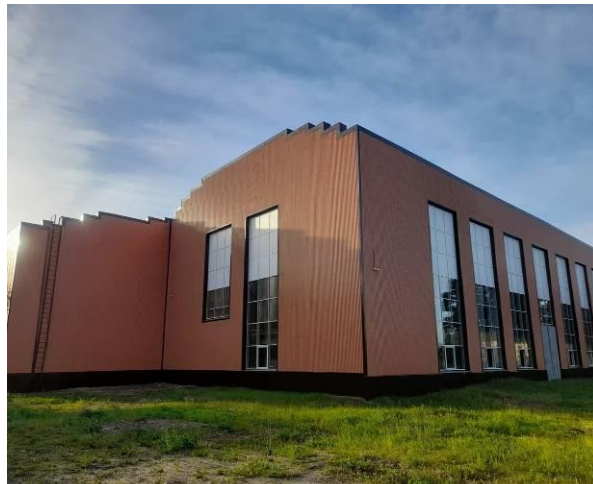
Фото 4. Общий вид на часть фасада здания в осях Я/1-А'.
