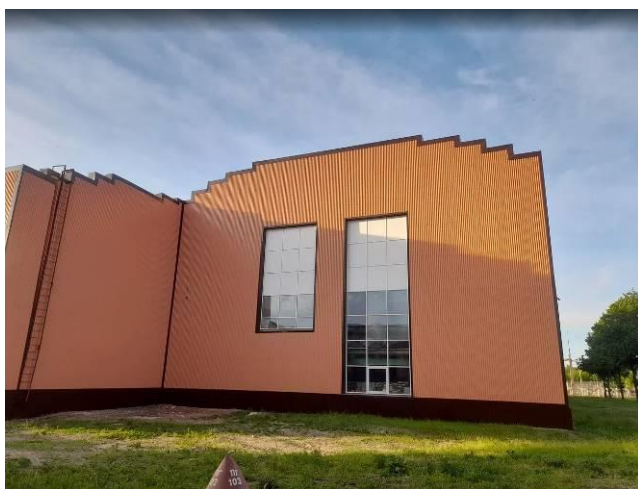
Фото 5. Общий вид на часть фасада здания в осях 30-9'.
