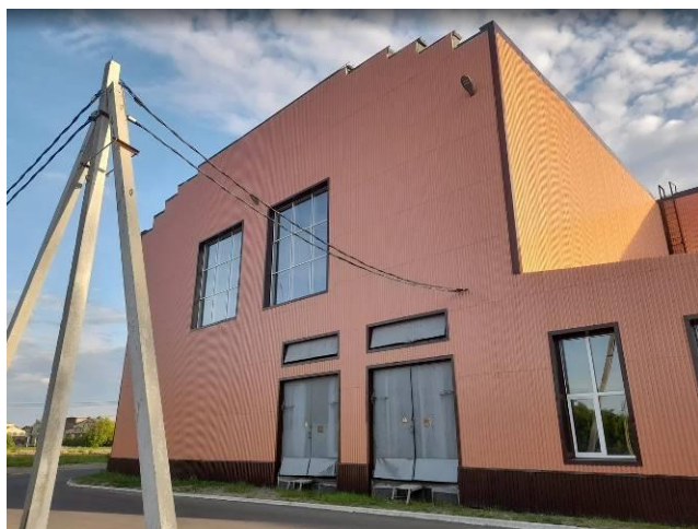
Фото 3. Общий вид на часть фасада здания в осях 9'-30.
