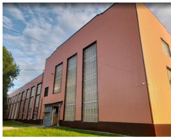
Фото 8. Общий вид на часть фасада здания в осях 9'-30.
