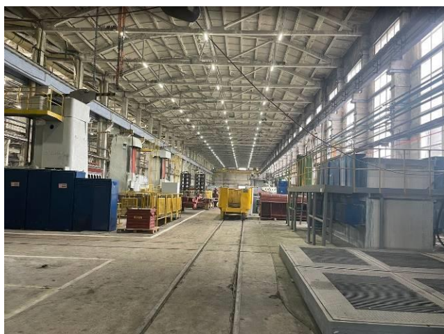
Фото 9. Общий вид на первый пролет здания в осях Ж-Вх25-5'
