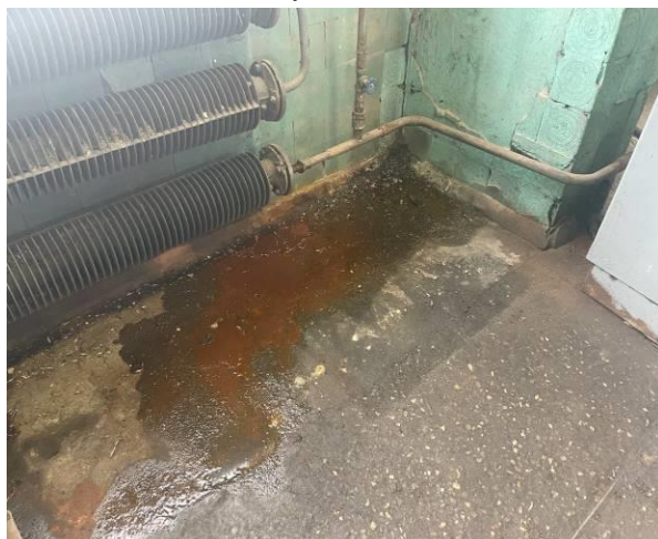
Фото 18. Застой воды из-за протечек коммуникаций.
