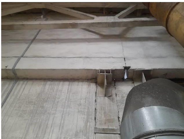
Фото 27. Вид на Обвязочную балку и консоли.
