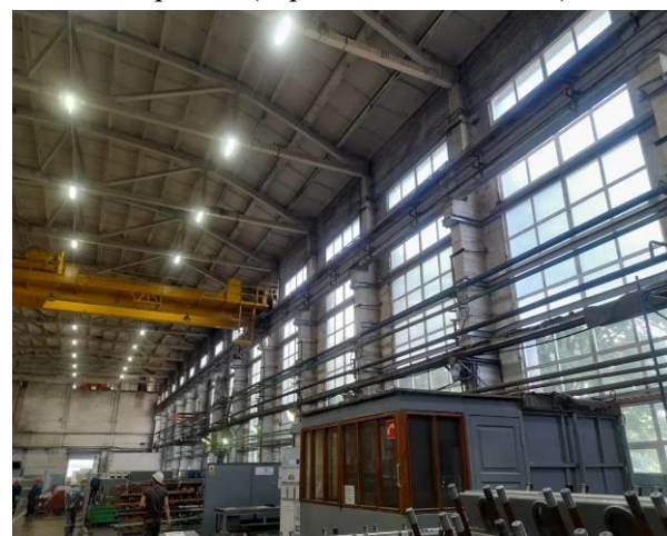
Фото 24. Общий вид металлические пояса усиления стен (УС-3).
