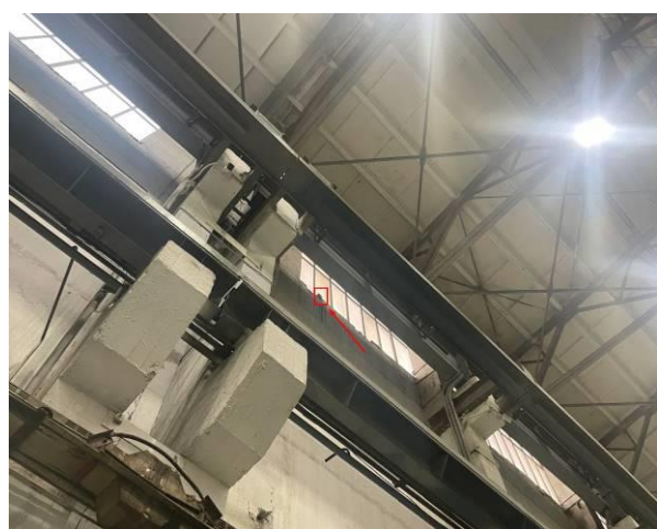
Фото 34. Отсутствие сцепления элементов кирпичной кладки с ц/п раствором.
