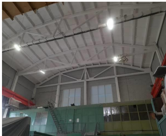
Фото 70. Скопление промышленной пыли. Застой воды. Наплывы рубероида. Замазывание остекления фонарей.
