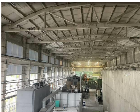
Фото 14. Общий вид на шестой пролет здания в осях Ц'-Щ'х25-5'
