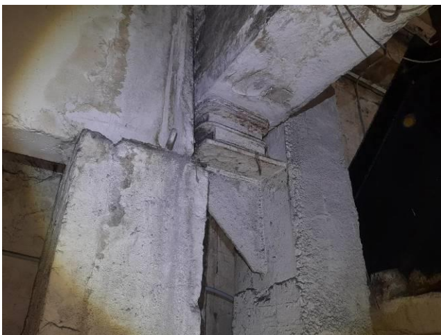
Фото 29. Вид на Обвязочную балку и консоли.
