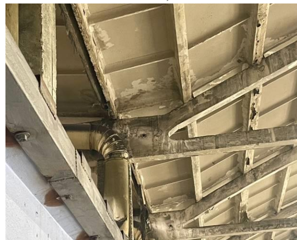
Фото 62. Нарушение крепления верхнего пояса подкрановой балки с конструкцией колонны (разрыв сварного шва).
