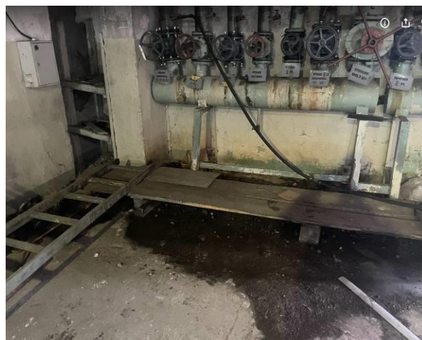
Фото 16. Застой воды из-за протечек коммуникаций.
