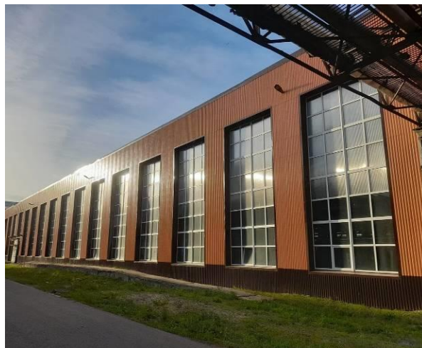
Фото 6. Общий вид на часть фасада здания в осях 30-9'.
