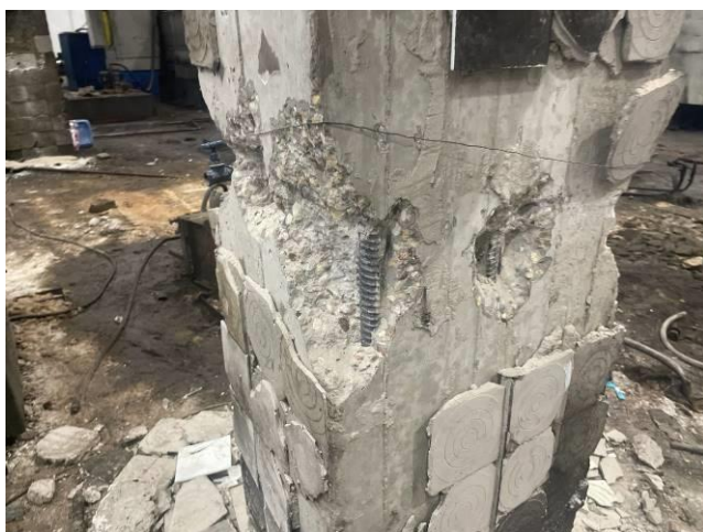
Фото 71. Вскрытие несущей конструкции с целью определения геометрических характеристик.
