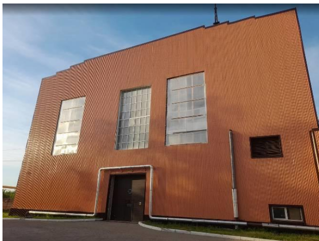
Фото 7. Общий вид на часть фасада здания в осях 30-9'.
