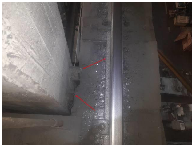
Фото 50. Вид на крепление верхних поясов подкрановых балок к конструкции колонны.
