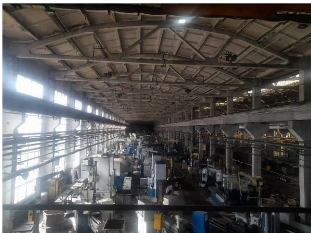
Фото 13. Общий вид на пятый пролет здания в осях Ц'-Щ'х25-5'
