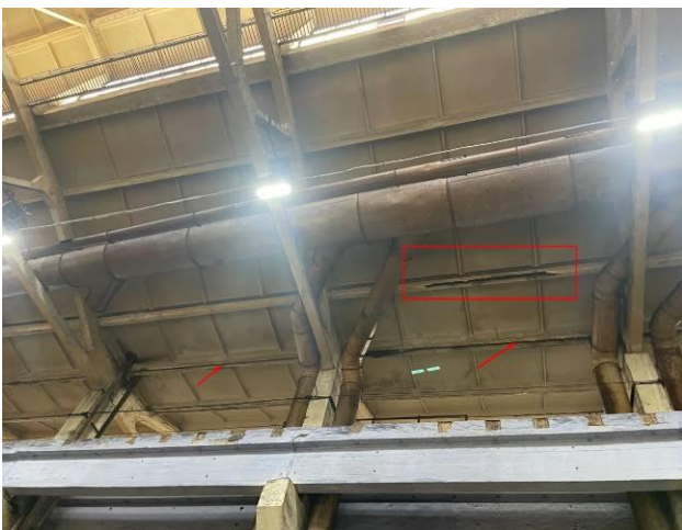
Фото 69. Скопление промышленной пыли. Застой воды.
