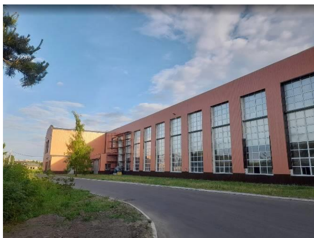
Фото 1. Общий вид на фасад здания в осях 9'-30.
