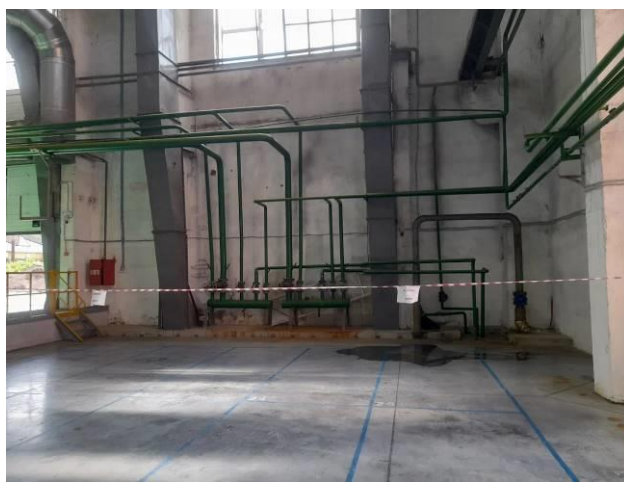
Фото 20. Застой воды из-за протечек коммуникаций.
