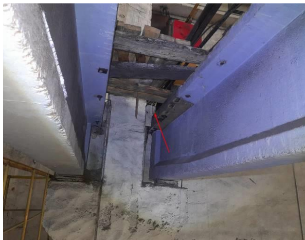
Фото 62. Нарушение крепления верхнего пояса подкрановой балки с конструкцией колонны (разрыв сварного шва).
