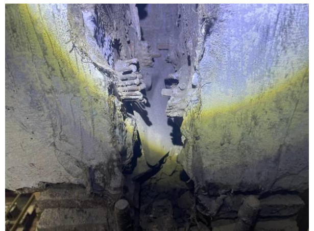
Фото 48. Вида на преднапрягаемую арматуру конструкции подкрановой балки.
