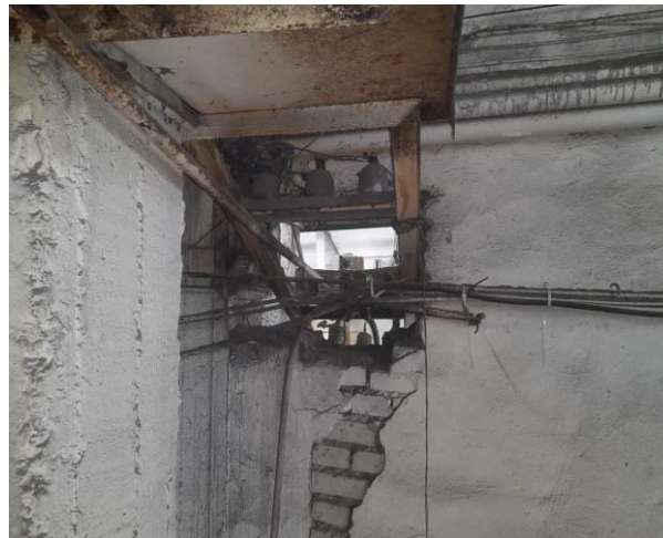
Фото 38. Неорганизованное технологическое отверстие.
