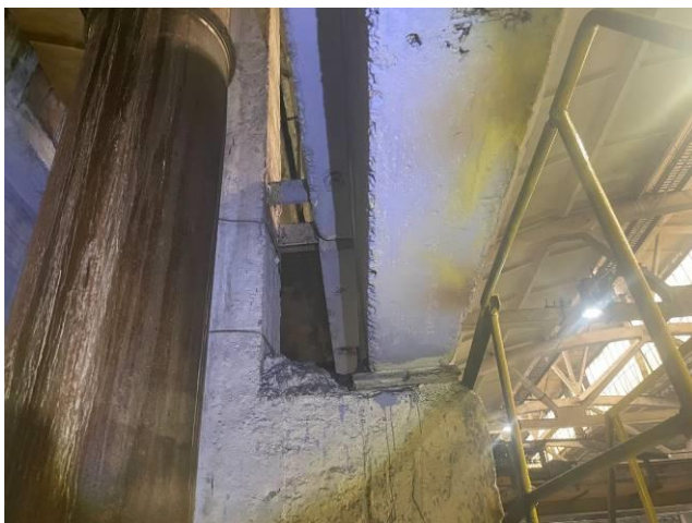
Фото 49. Вид на крепление верхних поясов подкрановых балок к конструкции колонны.
