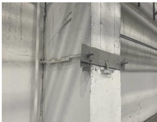
Фото 36. Вид на затяжку стеновой панели с колонной.
