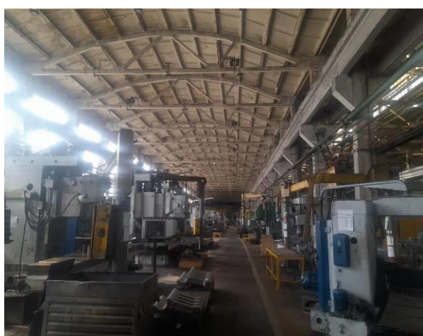
Фото 12. Общий вид на четвертый пролет здания в осях Т-Ц'х25-5'
