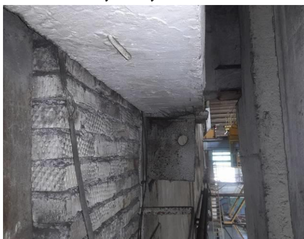
Фото 28. Вид на Обвязочную балку и консоли.
