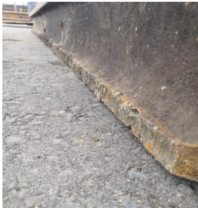
Фото №15. В конструкции «Глухое пересечение» использованы стыковые накладки распиленные пополам и затем приваренные под углом с использованием сварки.
