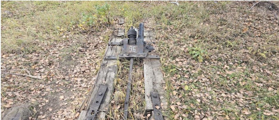
Фото №7. Неудовлетворительное состояние стрелочного перевода.
