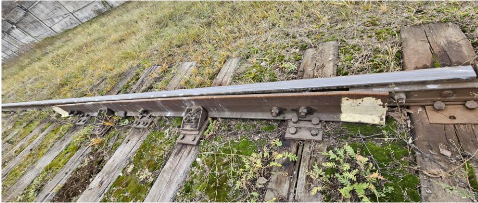
Фото №7. Неудовлетворительное состояние стрелочного перевода.
