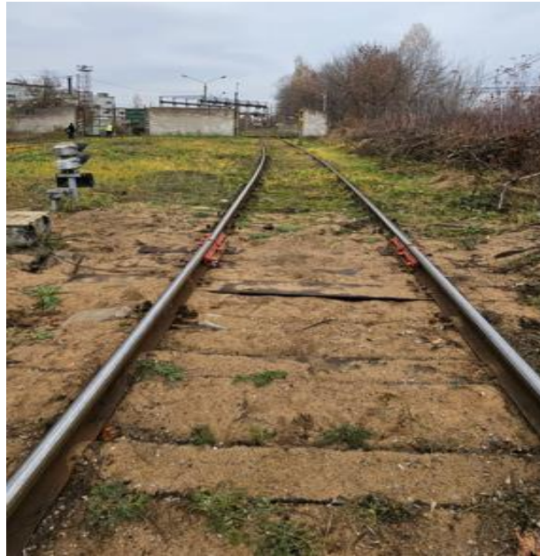
Фото №2. Вид от границы пути необщего пользования в сторону въездных ворот от границы пути необщего пользования.
