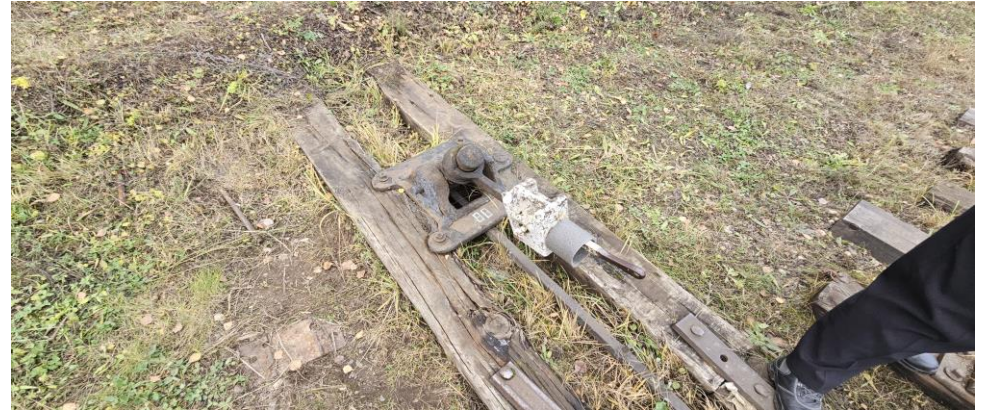
Фото №8. Не типовой элемент в стыковом соединении.
