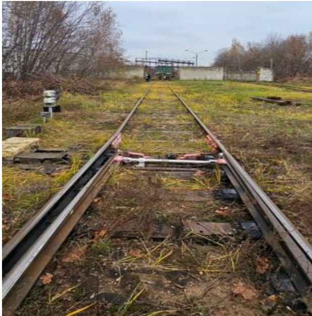
Фото №1. Вид от границы пути необщего пользования в сторону въездных ворот. Место начала обследования.
