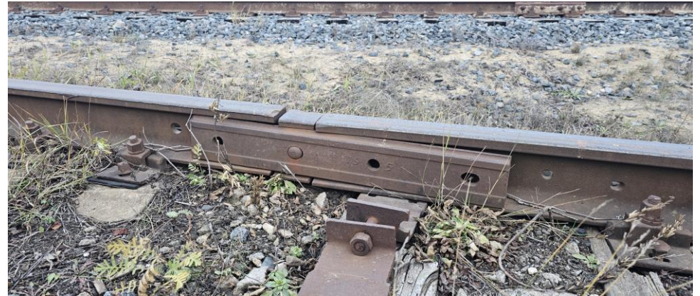
Фото №8. Не типовой элемент в стыковом соединении.
